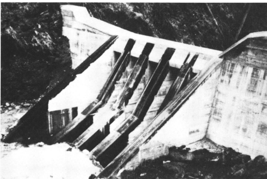
Abb. 6 Eine Sperre als Murbrecher im Luggauerbach (Bezirk St. Johann, Salzburg, erbaut 1982). Das Bauwerk muss den vollen Belastungen eines Murganges widerstehen können und ist in seinem Mittelteil in Scheiben aufgelöst, zwischen denen der Bach durchfließt. Die Sperre ist eine Weiterentwicklung des geknickten Rostes, der ein Aufschwimmen und Aufrollen des Treibholzes begünstigt und damit gegen Verkläusungen wirkt.
