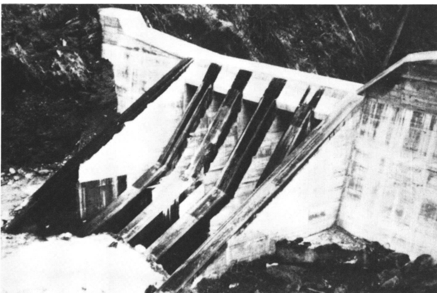
Abb. 6 Eine Sperre als Murbrecher im Luggauerbach (Bezirk St. Johann, Salzburg, erbaut 1982). Das Bauwerk muss den vollen Belastungen eines Murganges widerstehen können und ist in seinem Mittelteil in Scheiben aufgelöst, zwischen denen der Bach durchfließt. Die Sperre ist eine Weiterentwicklung des geknickten Rostes, der ein Aufschwimmen und Aufrollen des Treibholzes begünstigt und damit gegen Verklausungen wirkt.
