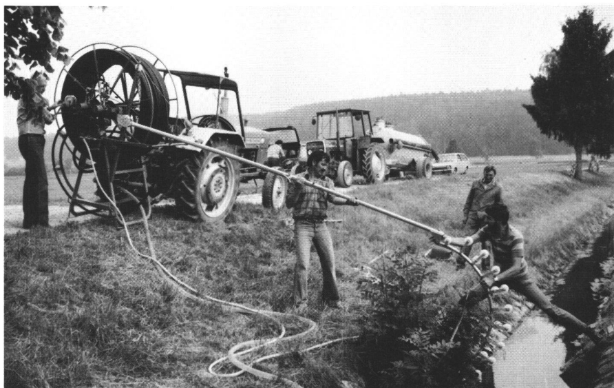
Abb. 3 Die Auswechslung des Teleskoparmes kann auch von einer Person allein bewerkstelligt werden.
