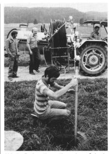
Abb. 1 Drainspülung über einen Schacht im Feld. Das Spülwasser stammt aus dem Druckfass im Hintergrund.
