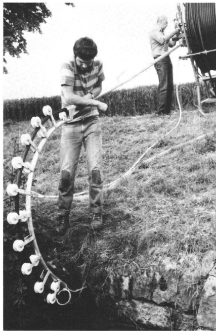
Abb. 2 Reinigung eines Sammlers vom Vorfluter aus.
