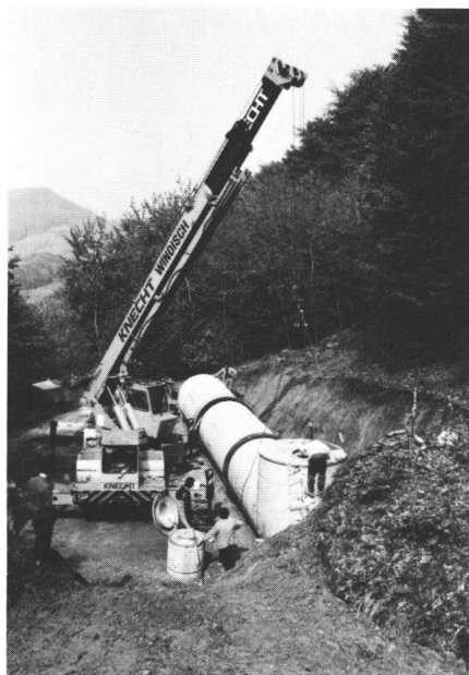
Montage des dreiteiligen Reservoirs
