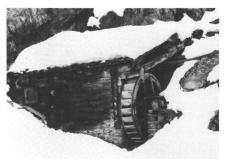
Dieses oberschlächtige Wasserrad aus Törbel im Vispertal VS trieb eine Hammerwalke für Textilgewebe an.
