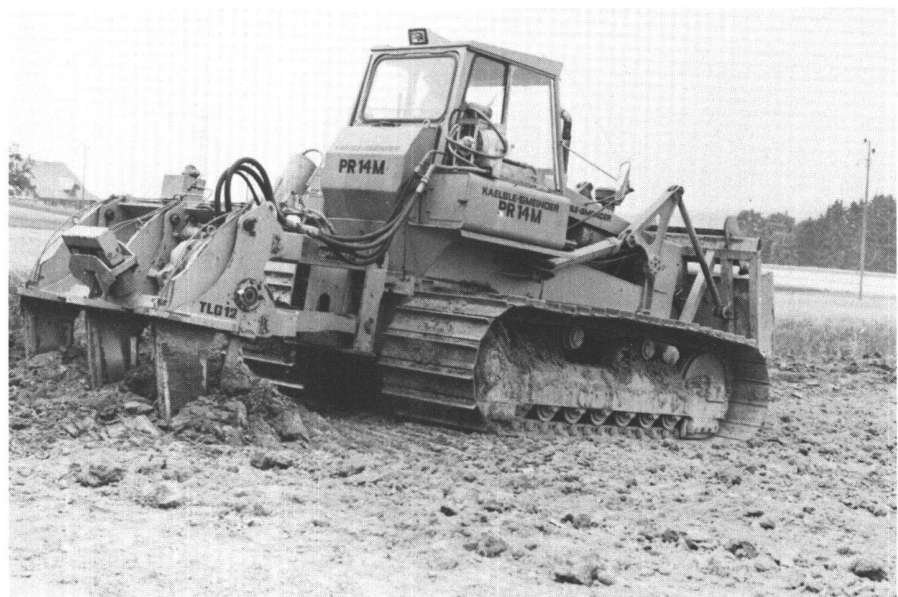
Abb.1 Der dreischarige Stechhubblockerer-TLG12, der bei der Lockerung der Versuchsfelder zum Einsatz kam.
