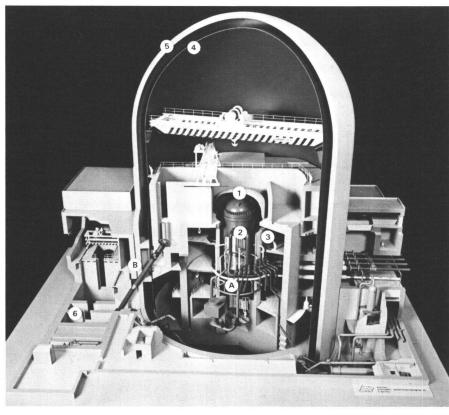
Abb. 7 Modell Reaktorgebäude mit Brennelementlager; 1 Reaktordruckgefäss, 2 Brennelemente, 3 Biologischer Schild, 4 Innere Sicherheitshülle (Containment), 5 Abschirmgebäude, 6 Brennelement-Lagerbecken, A CRD-Gehäuse, B Brennelement-Transportrohr. Die Vermessungsarbeiten bei den Montagen von A und B sind im Bericht beschrieben.
