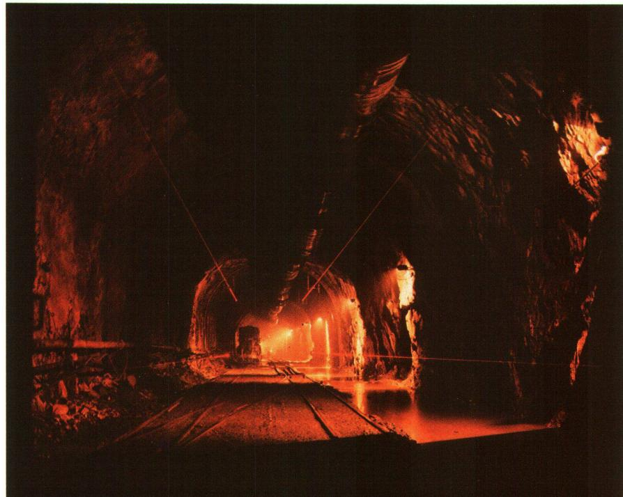
Fig. 1 Lasers de chantier, placés parallèlement, pour la conduite longitudinale des grandes machines de forage.
