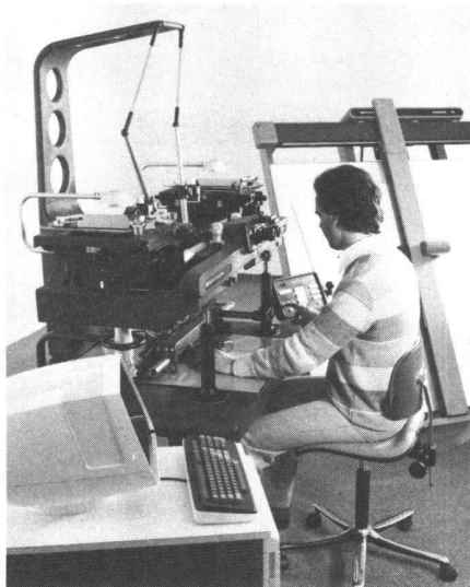
Abb.3 Eine besonders hohe Rationalisierungsstufe erreicht der Wild AG1 mit der Automationsausrüstung Wild Avioplot RAP.
