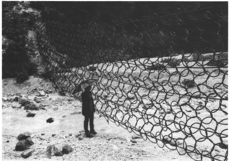
Abb. 11 Netzsperr im Werkstattgraben. Sie dient dem Rückhalt des Triebholzes, damit die selbsttätige Entleerung im untenliegenden Geschiebeablagungsplatz nicht durch Verklauungen behindert wird
