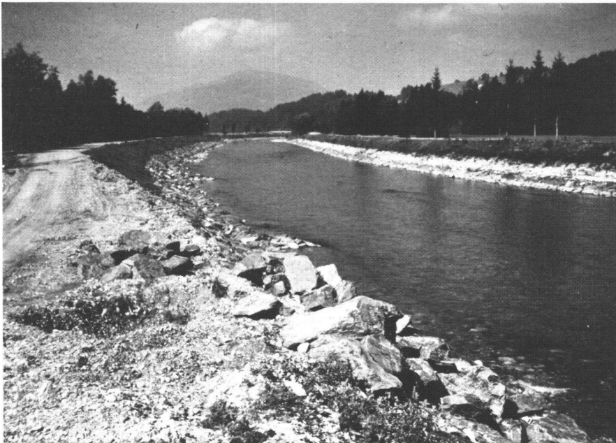
Abb. 2 Regulierte Gail kurz nach Beendigung der Bauarbeiten. Etwa 20 km unterhalb von Kötschach
