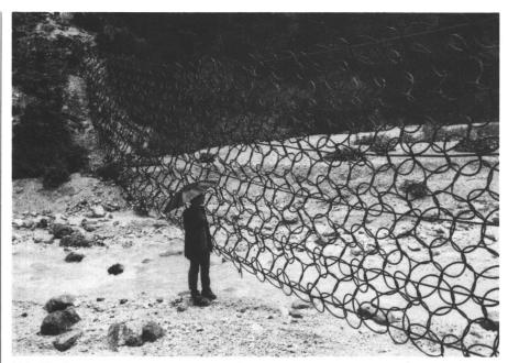
Abb. 11 Netzsperre im Werkstattgraben. Sie dient dem Rückhalt des Triebholzes, damit die selbsttätige Entleerung im untenliegenden Geschiebeablagerungsplatz nicht durch Verklausungen behindert wird
