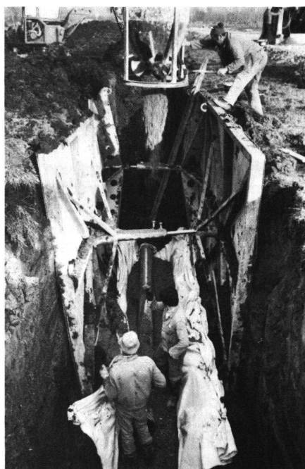
Abb. 9 Umhüllung des verlegten PVC-Rohres mit feinem Kiesmaterial mittels Krankübel aus dem Umschlaggerät.
