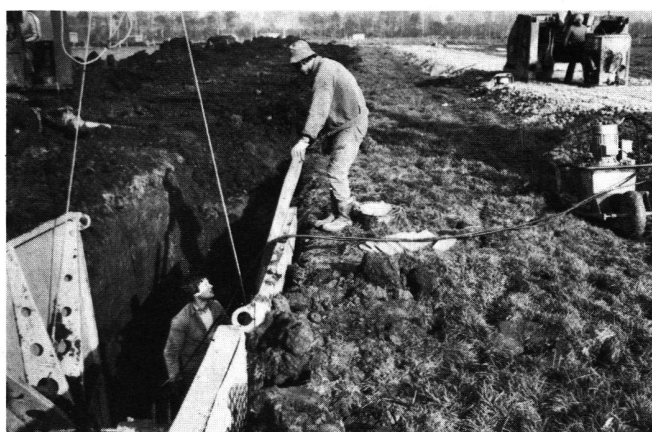
Abb. 8 Hydraulische Flächenspriessung (System Kaiser), bestehend aus zwei verstärkten Aluminium-Riffelblechtafeln und einem hydraulisch betätigten Spriess in der Mitte. Rechts die mobile Hydraulikpumpe samt Steuerung.
