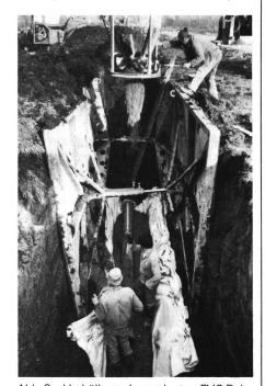
Abb. 9 Umhüllung des verlegten PVC-Rohres mit feinem Kiesmaterial mittels Krankübel aus dem Umschlaggerät.
