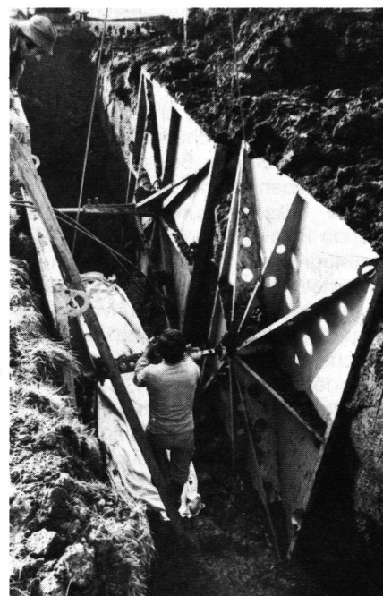
Abb. 10 Nach Umhüllung und Eindeckung des Rohres wird die hydraulische Spriessung entfernt und der Graben eingefüllt.
