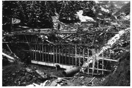
Abb. 2 Wildbachverbauung in Österreich: Auf dieser Baustelle im Simelacherbach (Mölltal, Kärnten) entsteht eine unter vielen Sperren mit Abmessungen bis zu einer Breite von 30 m und einer Höhe von 6,5 m. Auf dieser Höhe von 1600 m tieft der Bach sehr stark im Moränenschuttmaterial ein, weshalb seine Sohle fixiert werden soll.
