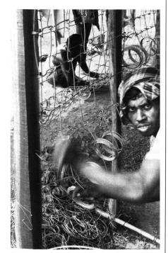
Abb.3 Wildbachverbauung in Nepal: Die benötigten Drahtschotterkörbe werden von ausgebildeten Arbeitern auf der Baustelle hergestellt. Die Topographie erlaubt keinen Strassenbau, und auch eine Seilbahn in die abgelegenen Berggebiete wäre viel zu teuer. Deshalb können keine grösseren Maschinen und nur die notwendigsten Materialien von menschlichen Trägern in oft tagelangen Märschen herbeigeschafft werden.
