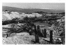
Abb. 6 Uferverbauung an der Zihl aus dem 16. Jahrhundert
