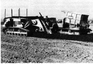
Abb. 5 Drainfräse Hoes Gigant und Kiestransportfahrzeug Unitrac
