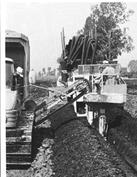
Abb. 4 Draingrabensfräsmaschine im Einsatz
