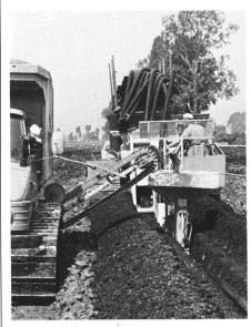
Abb. 4 Draingrabenfräsmaschine im Einsatz
