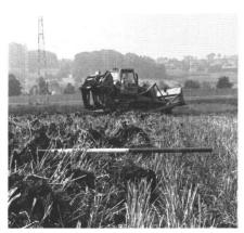
Abb. 7 Primärauflockerung ergibt eine Zunahme des Porenvolumens von 20–30%
