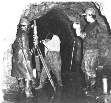
Fig. 7 Mise en station du gyroscope dans les galeries de drainage
