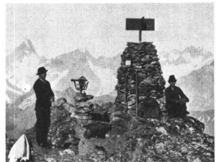
Signal und Station auf Pointe de Dronaz, Wallis (1894)
