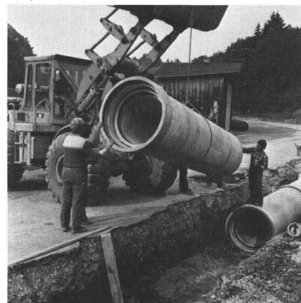
Abb. 1 Das Doppelrohr wird in den Graben gebracht, nachdem unmittelbar zuvor das Innenrohr mit Hilfe des Baggers ins Aussenrohr geschoben wurde.
