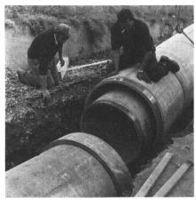
Abb. 2 Das Verbinden der Doppelrohre im Graben. Die Konzentrizität der beiden Rohre in der Einbaulage wird durch zwei Auflagerplatten gewährleistet, die an der Kupplung des Innenrohres angebracht sind.
