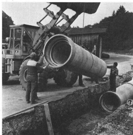
Abb. 1 Das Doppelrohr wird in den Graben gebracht, nachdem unmittelbar zuvor das Innenrohr mit Hilfe des Baggers ins Außenrohr geschoben wurde.
