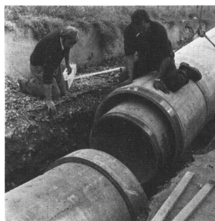
Abb. 2 Das Verbinden der Doppelrohre im Graben. Die Konzentrität der beiden Rohre in der Einbaulage wird durch zwei Auflagerplatten gewährleistet, die an der Kupplung des Innenrohrs angebracht sind.
