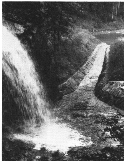
Abb. 9 Der Wasserfall der «Kleinen Saar» und deren Ableitung in einer gepflästerten Rinne in den Kiesfang des Saarfalles
