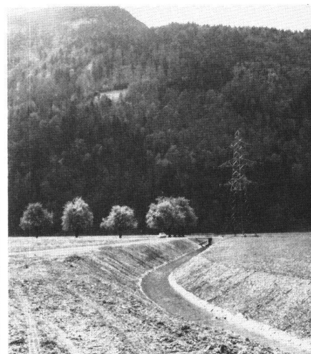
Abb. 3. Der neu ausgebaute Saschielbach
