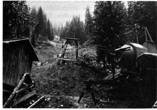
Abb. 2 Typische Wildbachbetonbaustelle auf 1400 m im Mödritschbach bei Irschen im Drautal (E = 7,7 km², Talzuschubprobleme): Links Arbeiterlager, rechts Betonmischer mit dem Beginn der Seilbahn, welche den Beton zur eigentlichen Baustelle hinaufbefördert.
