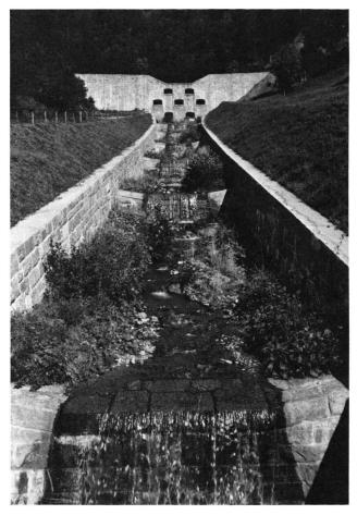
Abb. 12 Grosse Geschiebestausperre am Schluchtausgang des Schrimbaches im Maltatal (Siehe auch Abb. 5). Trotz der grossen Dohlen findet keine selbsttätige Entleerung der Sperre statt. Als weitere Sicherung des untenliegenden Dorfes wurde einige hundert Meter bachabwärts auf dem grossen Schwemmkegel ein Geschiebeablagerungsplatz gebaut.
