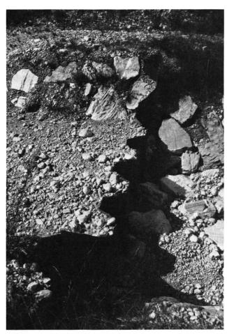
Abb. 7 Abtreppung des Rauthbaches im Rosental mittels Larssen-Spundwandbohlen (E = 0,8 km², HQ = 2,0 m³/sec.). Siehe Text 5.3.1.
