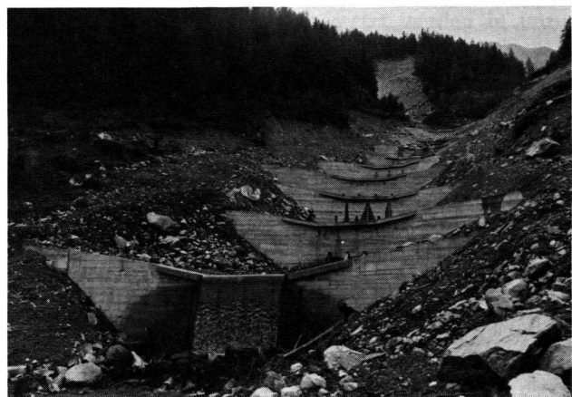
Abb. 9 Verbauung im Wollinitzbach im Mölltal nach der Hangexplosion von 1966. Im Hintergrund rechts der Bildmitte die Abbruchstelle der 200\,000 \text{ m}^3 Moränenmaterial (Siehe Text 6.1). Man beachte das typische, flache Murenprofil der Sperren.
