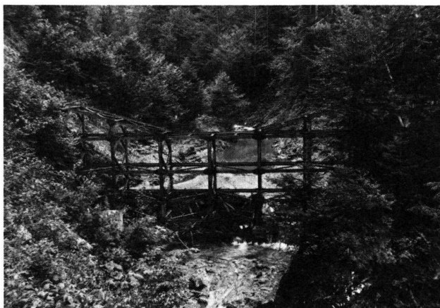
Abb. 8 Gittersperre als Versuch im Kirchbachgraben (Gailtal; E = 17 \text{ km}^2 , HQ = 80 \text{ m}^3/\text{sec.} ). Die Sperre wurde bereits einmal völlig hinterfüllt und maschinell geleert. Ein Problem ist u. a. das Holz: Bereits grössere Äste bleiben im Fachwerk hängen. Siehe Text 5.3.2.
