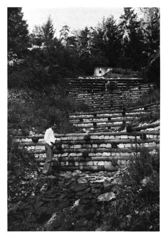
Abb. 4 Diese Runse bei Kras (Drautal bei Villach) wurde gegen Erosion und Rutschung mit Steinkästen verbaut, da das oben sichtbare Reservoir gefährdet war. Die Methode eignet sich in diesem sehr schattigen und feuchten Hang gut.
