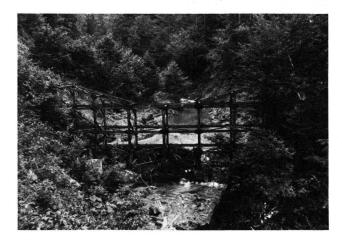
Abb. 8 Gittersperre als Versuch im Kirchbachgraben (Gailtal;  $E=17~\rm{km^2},\,HQ=80~\rm{m^3/sec.}$ ). Die Sperre wurde bereits einmal völlig hinterfüllt und maschinell geleert. Ein Problem ist u. a. das Holz: Bereits grössere Äste bleiben im Fachwerk hängen. Siehe Text 5.3.2.
