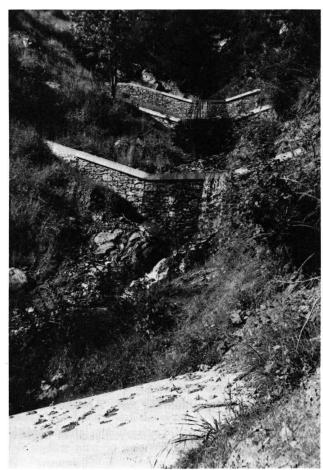
Abb. 5 Der Schrimbach im Maltatal ( $E=3,4\,\mathrm{km^2},\,\mathrm{HQ}=15,4\,\mathrm{m^3/sec.}$ ) wurde auf 1300 m mittels Drahtschottersperren abgetreppt. Die Methode eignete sich sehr gut, da nur wenige Sperren zu bauen waren und eine Erschliessungsstrasse fehlte.
