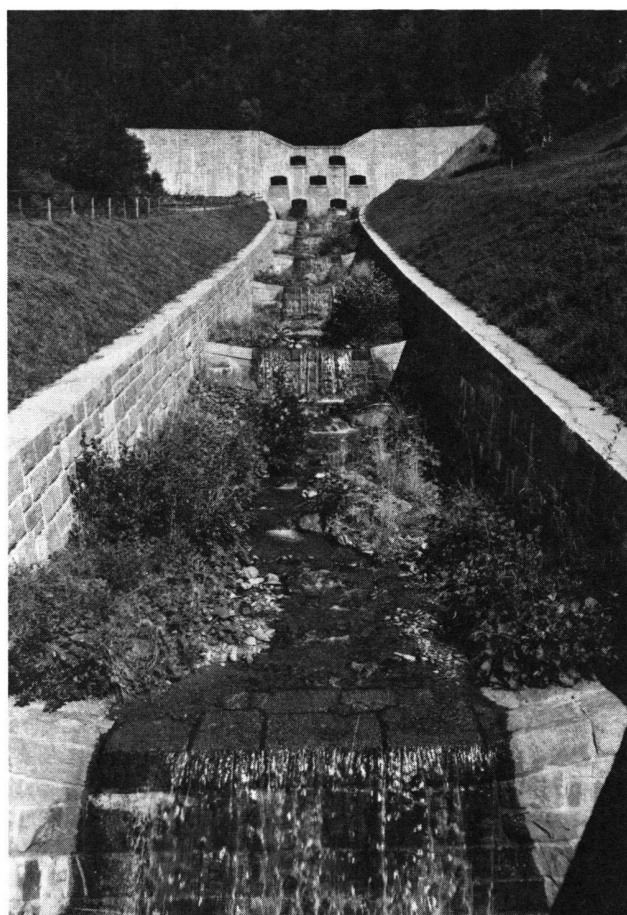
Abb. 12 Grosse Geschiebestausperre am Schluchtausgang des Schrimmbaches im Maltatal (Siehe auch Abb. 5). Trotz der grossen Dohlen findet keine selbsttätige Entleerung der Sperre statt. Als weitere Sicherung des untenliegenden Dorfes wurde einige hundert Meter bachabwärts auf dem grossen Schwemmkegel ein Geschiebeablagungsplatz gebaut.
