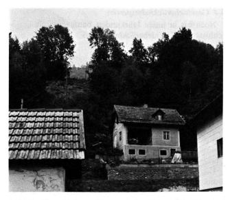
Abb. 10 Eine «kleinere» Hangexplosion löste sich bei Ferndorf oberhalb des mittleren Hauses und durchstiess ein Zimmer (die Mauer wurde nicht nachträglich noch sauber herausgetrennt; dieses Bild präsentierte sich unmittelbar nach der Hangexplosion). Der übrige Teil des Hauses blieb unbeschädigt.
