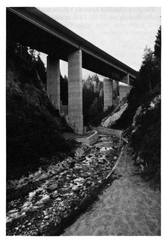
Abb. 14 Die Liesertal-Autobahn überquert den Steinbrückenbach: Zum sicheren Schutz der Brückenpfeiler und wegen der engen Platzverhältnisse musste der Bach über eine kurze Strecke zwischen Betonmauern kanalisiert werden.
