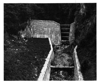
Abb. 13 Balkensperre im Wollinitzbach (Siehe auch Abb. 9). Die grossen Öffnungen bewirken meistens eine selbsttätige Reinigung der Sperrenhinterfüllung; andernfalls können die Balken nach unten entfernt werden.
