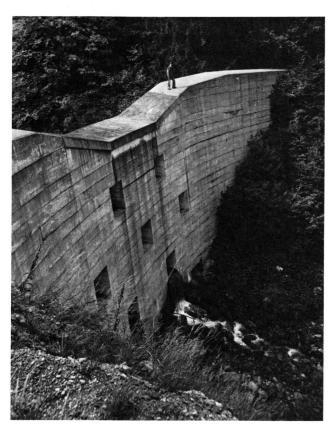
Abb. 1 Geschieberückhaltesperre im Gödersdorfer-Feistritz-Bach: Der Jungschuttbach (Einzugsgebiet  $E=6\,\mathrm{km^2}$ , Dimensionierungshochwasser HQ=25,4 m³/sec.) bringt aus den Karawanken grosse Mengen Kalk und Mergel. Er würde ohne Geschieberückhalt im Rosental regelmässig weite Flächen übermuren.
