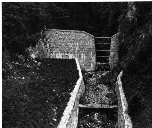
Abb. 13 Balkensperre im Wollinitzbach (Siehe auch Abb. 9). Die grossen Öffnungen bewirken meistens eine selbsttätige Reinigung der Sperrenhinterfüllung; andernfalls können die Balken nach unten entfernt werden.
