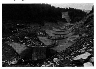
Abb. 9 Verbauung im Wollinitzbach im Mölltal nach der Hangexplosion von 1966. Im Hintergrund rechts der Bildmitte die Abbruchstelle der 200 000 m³ Moränenmaterial (Siehe Text 6.1). Man beachte das typische, flache Murenprofil der Sperren.
