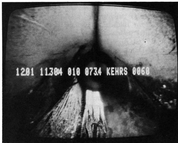
Abb. 3 Wurzeleinwüchse in ZR Ø 60 cm. Die Stränge erreichen eine Länge von mehreren Metern.
