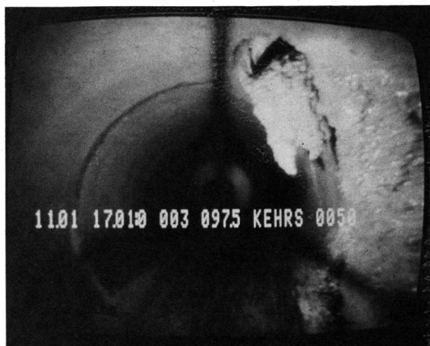
Abb. 4 Kalkausscheidung bei Rohreinmündung.
