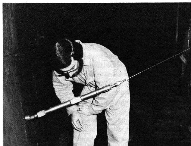
Die Messpunkte können zwischen 1 m und 50 m auseinanderliegen, und der Messbereich für Längenänderungen beträgt 100 mm. Die Genauigkeit einer Messung bei Drahtlängen unter 20 m beträgt  $\pm 0,02$  mm, für grössere Drahtlängen etwa  $\pm 1 \cdot 10^{-6}$  der Distanz.
