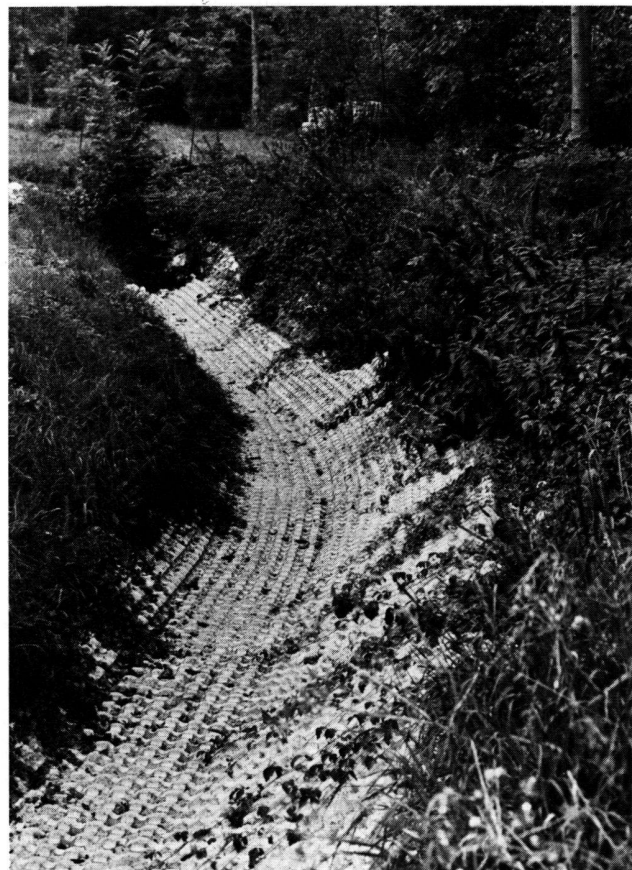
Abb. 4 Die UK-Wasserverbauung passt sich dem Gelände an
