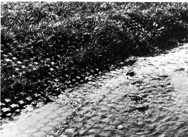
Abb. 7 UK-Wasserbausystem: Die unsichtbare Armierung des Bodens
