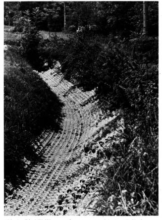
Abb. 4 Die UK-Wasserverbauung passt sich dem Gelände an
