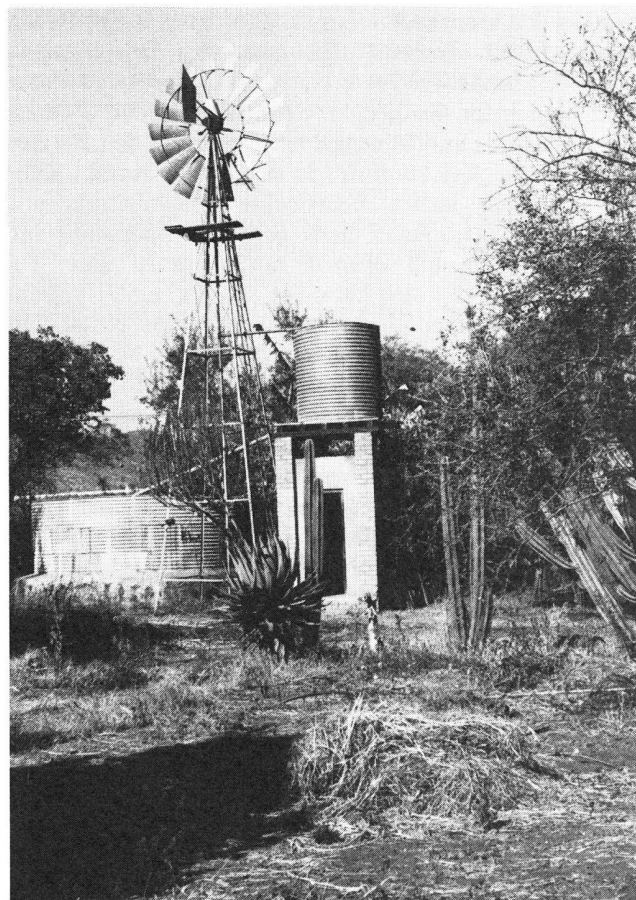
Abb. 2 Wasser ist eines der Hauptprobleme in Südafrika. Viele Farmen haben eigene Bohrlöcher mit Windmotoren. Dadurch ist wenigstens die Trink- und Brauchwasserversorgung gesichert.
