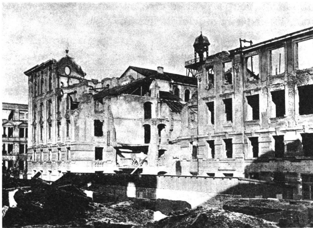
Fig. 4 Le bâtiment du service du cadastre de Bavière en 1945
