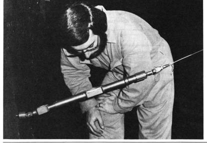
Deformationsmessung eines Tunnelprofils mit dem Distometer ISETH
