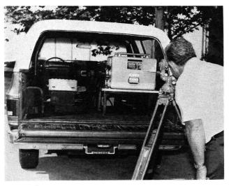
Abb. 3 Übernahme eines Azimutes aus der Trägheitsmesseinheit mit Hilfe eines exzentrisch aufgestellten Theodoliten.
