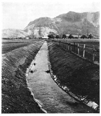
Abb. 8 Naturverbunden ausgebauter Kanal im Meliorationsgebiet der Saarebene. Kiessohle, Natursteinpflästerung und Rasenböschung geben den Fischen Lebensraum und wirken bestimmt nicht störend im Landschaftsbild.
