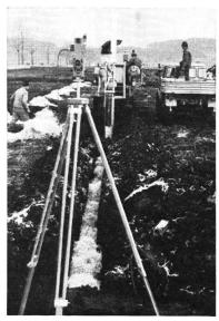
Abb. 10 «Hoes-Gigant» im Einsatz. Im Vordergrund das aufgestellte Lasergerät, gegen den untern Bildrand hin ist der Graben auf ca. 3 m<sup>1</sup> beim Zusammenschluß mit Sammler ausgebaggert, damit der Verlegekasten angesetzt werden kann.
