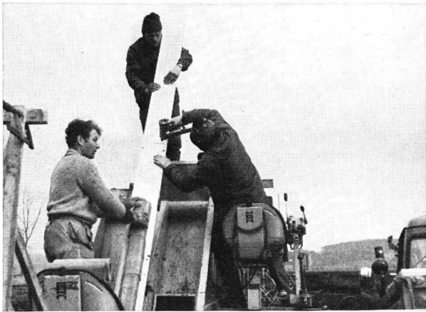
Abb. 5 «Hoes Gigant». Einsatz im Torf, Grabentiefe ca. 1,2 m (Wechselagen mit Sand und Seekreide) Tonrohre (4kantige Form) \varnothing 80 mm auf Holzbrettunterlage. Die Bretter werden laufend zusammengenagelt. Bei runden Rohren werden Bretter mit Randleisten verwendet (siehe Abb. 11).
