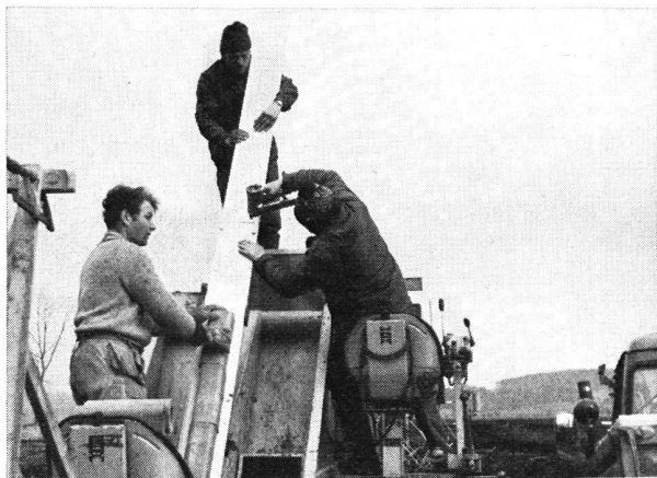
Abb. 5 «Hoes Gigant». Einsatz im Torf, Grabentiefe ca. 1,2 m (Wechsellagen mit Sand und Seekreide) Tonrohre (4kantige Form) Ø 80 mm auf Holzbrettunterlage. Die Bretter werden laufend zusammengeagelt. Bei runden Rohren werden Bretter mit Randleisten verwendet (siehe Abb. 11).
