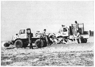
Abb. 7 «Hoes» zu Unimog. Einsatz in Hügelgebiet (sandiger Lehm), Grabentiefe 1,1 m; Rohrmaterial: Ton Ø 80 mm.
