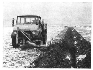
Abb. 8 Verfüllschnecke «Hoes» an Unimog. Verfüllen eines gefrästen, 28 cm breiten Grabens (sandiger Lehm).
