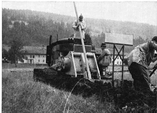
Abb. 4 «Hoes Gigant» (siehe Abb. 1). Einsatz in Hochmoor, Grabentiefe über 2 m, Rohrmaterial KD-Stangenrohre (Somo, 5 m Länge). Die beiden rechteckigen Tafeln mit Fadenkreuz dienen zur Abbildung des Laserstrahles, die Tafel rechts besteht aus Plexiglas. Baujahr 1971; Gewicht 11 500 kp; Bodenpressung 0,25 kp/cm 2 ; Grabenbreiten für Drainagen 280 mm; für ZR-Leitungen bis \varnothing 400 mm 560 mm; Grabentiefen 2000 mm, mit Zusatzausrüstung bis 3000 mm; Motorenleistung 110 PS; Arbeitsgeschwindigkeit bis zu 3 km/h; Fahrgeschwindigkeit bis 4,5 km/h; Sohlensteuerung durch den Fahrer über die Hydraulik durch visuelle Anpassung (Profiltafeln oder Laserstrahl) (siehe Abb. 10). Anschaffungspreis inkl. Zusatzausrüstung 1971 Fr. 220 000.–.
