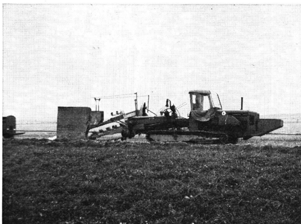
Abb. 6 «GFP 2». Mit angehobenem Verlegekasten (links). In der Mitte ist das Fräswerkzeug, rechts der Maschinenteil mit der Kabine für den Fahrer erkennbar.
