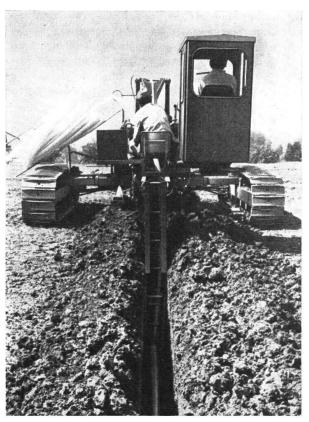
Abb. 3 «GFP 3», Verlegung von KD-Flex (Werkphoto).
