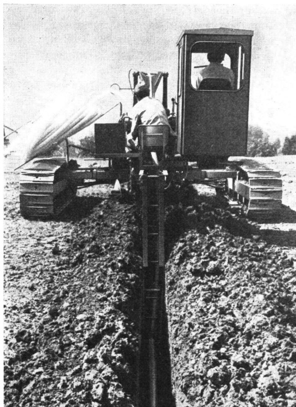
Abb. 3 «GFP 3», Verlegung von KD-Flex (Werkphoto).
