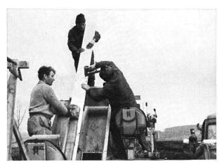
Abb. 5 «Hoes Gigant». Einsatz im Torf, Grabentiefe ca. 1,2 m (Wechsellagen mit Sand und Seekreide) Tonrohre (4kantige Form) Ø 80 mm auf Holzbrettunterlage. Die Bretter werden laufend zusammengenagelt. Bei runden Rohren werden Bretter mit Randleisten verwendet (siehe Abb. 11).
