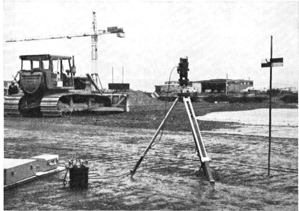
Baulaser-Einsatz für Planierungsarbeiten bei den Erweiterungsbauten des Flughafens Kloten-Zürich. Die Baumaschine wird durch den Laserstrahl geführt.
