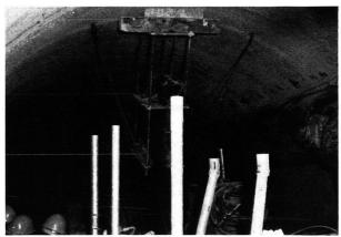
Abb. 4 Instrumentenplattform mit Lasertheodolit und Batterie
