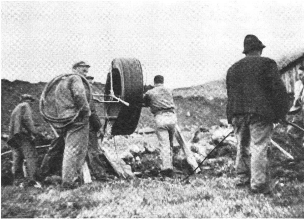
Abb. 7 Das Verlegen der Milchleitung von der Alp Avouin ob Grimentz. Das Kaliber der Leitung beträgt 11 mm. Die Milchleitungen werden stets von oben nach unten verlegt
