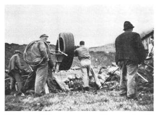
Abb. 7 Das Verlegen der Milchleitung von der Alp Avouin ob Grimentz. Das Kaliber der Leitung beträgt 11 mm. Die Milchleitungen werden stets von oben nach unten verlegt
