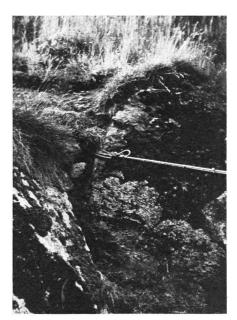
Abb. 9 Führen der Milchleitung, in Zoreseisen verpackt, über eine Feldpartie in St. Martin
