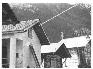
Abb. 10 Die Milchleitung, am Stahlkabel aufgehängt, wird zwischen den Häusern hindurch oberirdisch in die Käserei von Grimentz geführt. Die Briden, mit welchen die Leitung am Stahlkabel befestigt wurde, sind sehr gut sichtbar. Da es sich hier um eine Sommerleitung handelt, erübrigt sich eine Heizung, dagegen würde die Leitung heute vor der Erwärmung durch die Sonne mit einer Isolation geschützt
