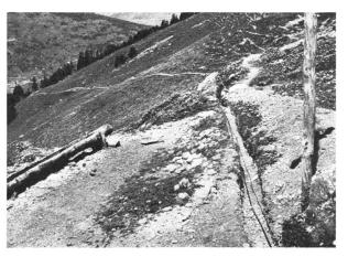
Abb. 8 Die eingelegte Versuchsleitung (Kaliber 11 mm) mit Telephonkabel vor dem Eindecken des Grabens. Leitung von St. Martin
