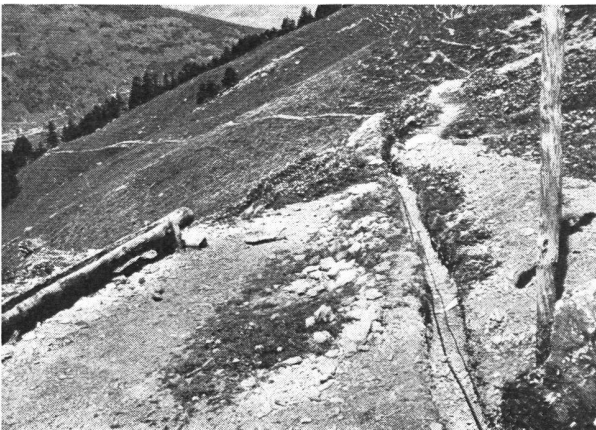
Abb. 8 Die eingelegte Versuchsleitung (Kaliber 11 mm) mit Telefonkabel vor dem Eindecken des Grabens. Leitung von St. Martin
