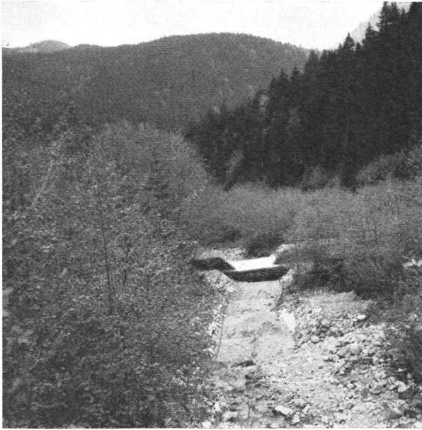
Abb. 3 Mit Querwerken, gepflasterter Bachsohle und Grünverbau wird ein Zufluß des Halblechs saniert. Die Geländerutschungen sind bereits vermindert worden.
