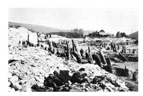
Uferverbauung an der Zihl aus dem 16. Jahrhundert; im Hintergrund das Fanelschlößehen.
