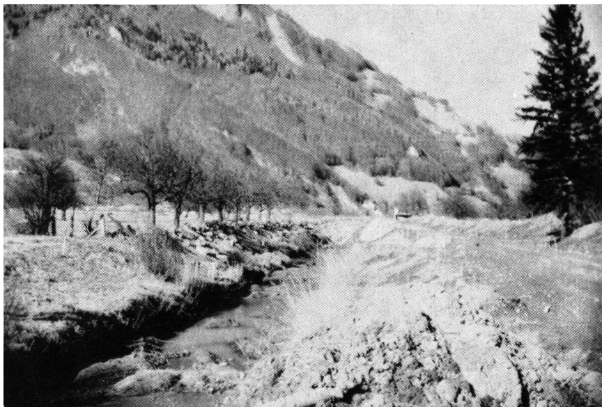
Vilterser-Wangser-Kanal. Blick vom Bahnhof Sargans nach Vild. Im Vordergrund noch der alte Zustand. In Bildmitte sind die Vertiefungsarbeiten ersichtlich. Zustand 1964.
