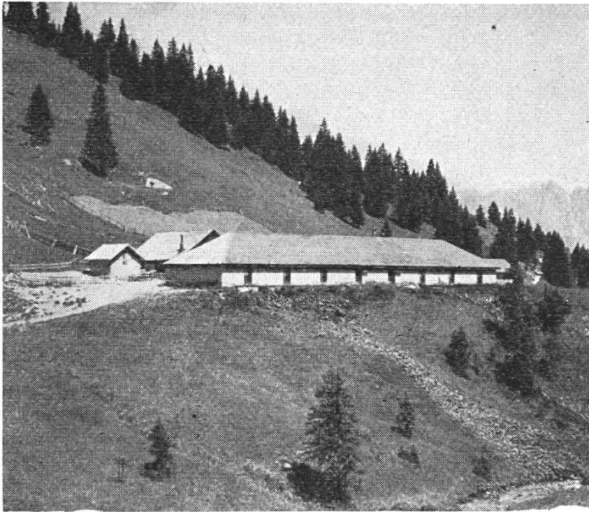
Bild 1 Querstall Alp Kohlschlag, Untersäß, Gemeinde Mels, 1893/94; Baukosten Fr. 13000.-.
