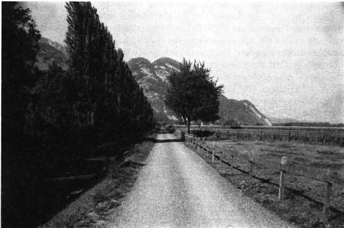
4. Korrigierter Saarkanal mit Parallelweg, unter Schonung des linksufrigen alten Baumbestandes. Die durch die Vertiefung des Kanals notwendig gewordene Verbreiterung erfolgte ausschließlich auf der rechten Seite. Ausbau mit Kiessohle, Natursteinpflasterung. Linkes Ufer Staudenausschlag, rechtes Ufer Rasenböschung. Melioration der Saarebene.
