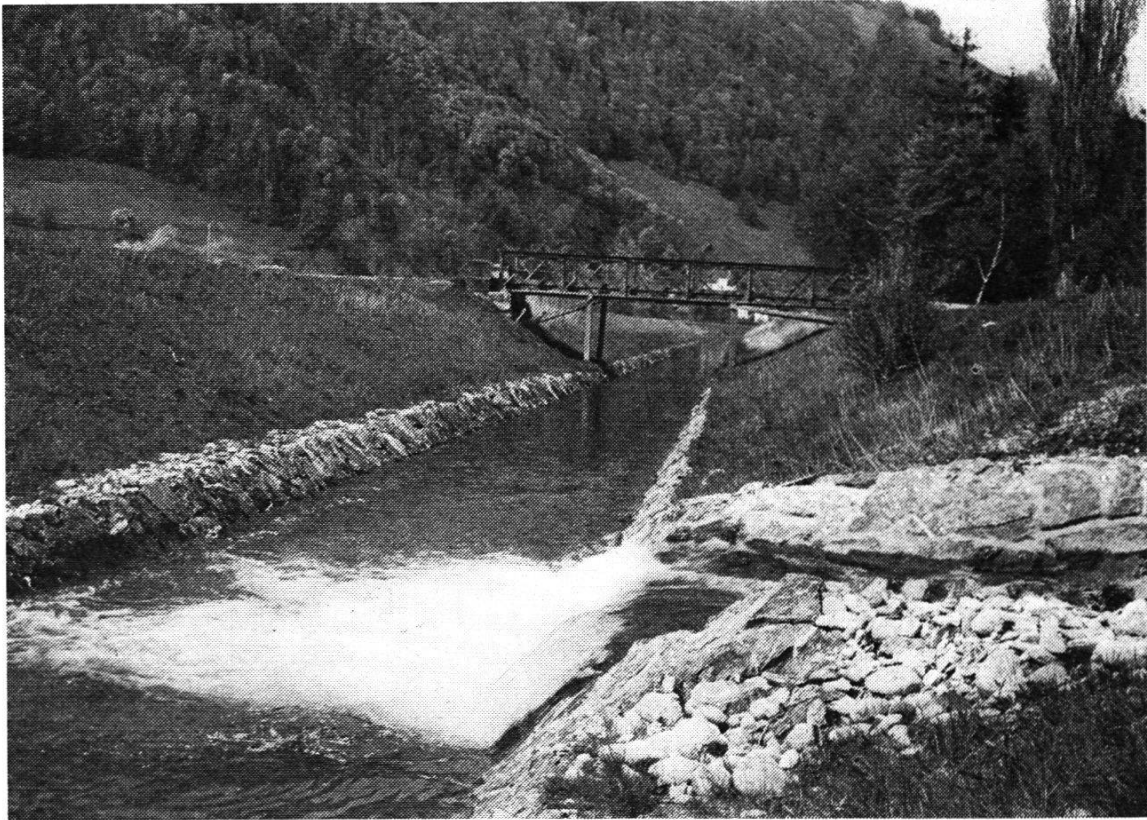
5. Neuer, natürlich ausgebauter Vilterser-Wangser Kanal, mit Einmündung eines Vorflutgrabens, unter Erhaltung des alten Baumbestandes. Melioration Saarebene.
