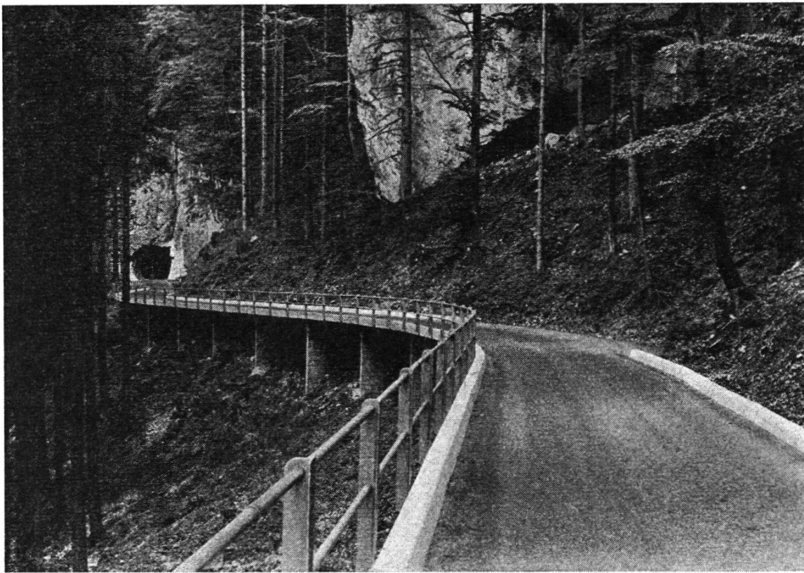
Bild 3: Fertiggestellter Lehnenviadukt als Fortsetzung einer Tunnelpartie; Fahrbahnbreite 3,60 m, Längsgefälle 10,5%
