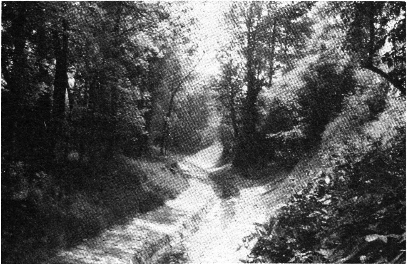
Bild 3: Korrigierter Altstätter Stadtbach, im Zuge der Melioration der Rheinebene. Früher ein unansehnliches Gerinne, eine Abfallgrube – heute ein Musterbeispiel: Natursteinpflasterung unter Schonung des alten Baumbestands.
