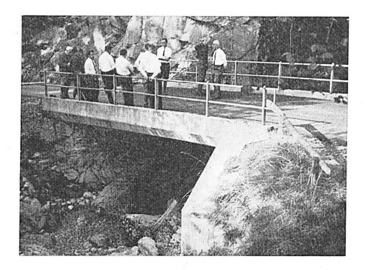
Abb. 2: Dörflerbergstraße, Brücke über den Rufibach. Talseitiges Widerlager auf anstehendem Fels, bergseitiges betoniert. Länge 10 m, Breite 4,4 m. Die neun vorgespannten Eisenbetonträger wurden vorfabriziert und an Ort und Stelle fertig verlegt. Anschließend erfolgte die Betonierung der Brücke. Tragkraft 10 t Achslast und Zuschläge gemäß Normen SIA. Baukosten Fr. 19000.—.
