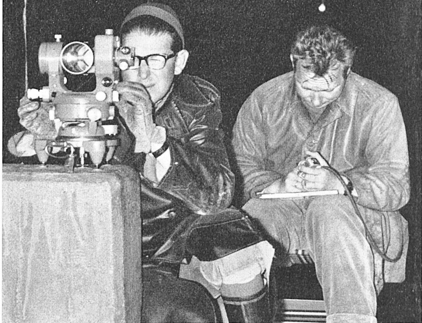
Kern Aarau liefert vollständige Präzisions-Meßausrüstungen zur Absteckung, Kontrolle und Überwachung von Bauwerken jeder Art. Besonders bei Deformationsmessungen an Stausemäuer und -dämmen von Wasserkraftanlagen spielen die zuverlässigen und präzisen Kern-Instrumente eine immer wichtigere Rolle.
