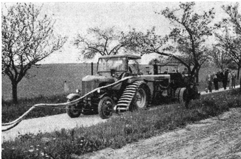
Bild 4. Straßenstabilisierung in Niederösterreich
