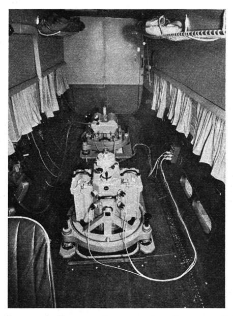
Fliegermeßkammern im Vermessungsflugzeug eingebaut. Vorn automatische Plattenkamera Wild RC7a, hinten automatische Filmkamera Wild RC8. Eine Aufnahmemission kann 5 Stunden dauern und 400 bis 600 Aufnahmen umfassen
