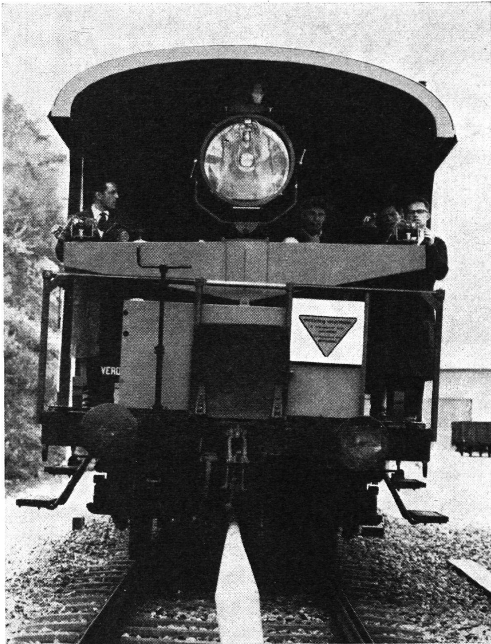
Frontale Ansicht des Wagens mit der betriebsbereiten Aufnahmeapparatur. Der Arm ist stark geneigt zur Kompensation der Querneigung. Mitte oben Scheinwerfer, links und rechts auf dem Arm die Kameras, unten das Rohr zu den Nummerntafeln
