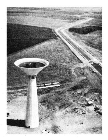
Abb. 3. Der Sekundärkanal bringt das Wasser an das Entnahmepumpwerk (im Bild nicht sichtbar rechts außen). Dieses fördert über den Wasserturm in das Druckrohrnetz zu den Regnern
