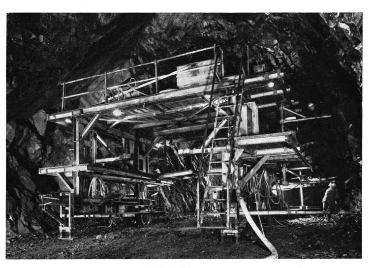
Bild 3. Bohrwagen
