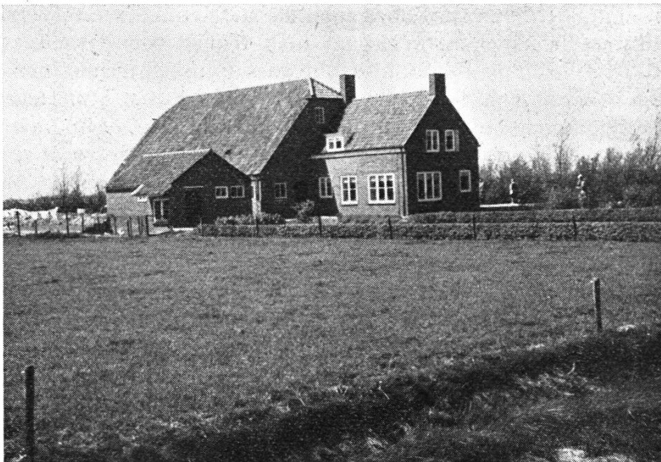
Bild 6. Hofsiedlung auf Duiveland
