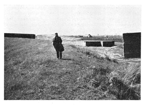
Bild 5. Die letzte Dammlücke bei Ouwerkerk wurde mit riesigen Beton-Caissons geschlossen
