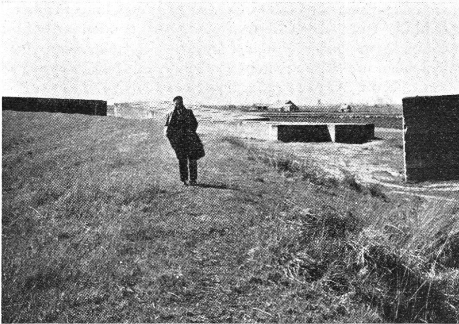
Bild 5. Die letzte Dammlücke bei Ouwerkerk wurde mit riesigen Beton-Caissons geschlossen
