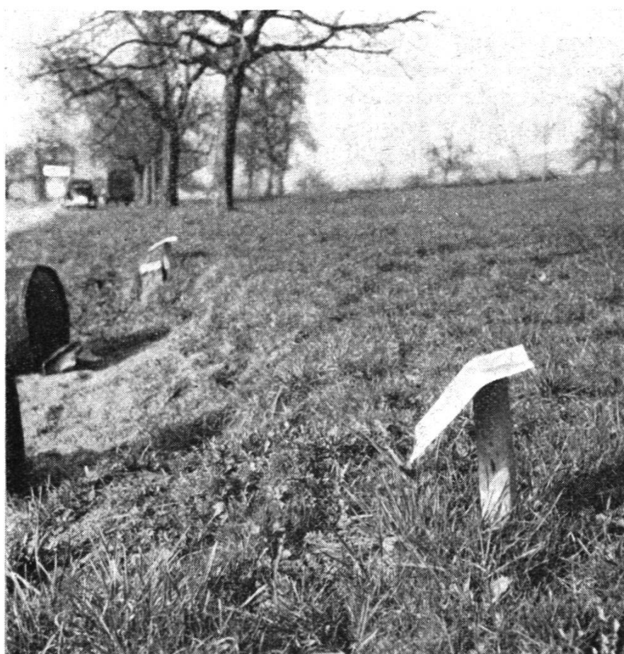
Abb. 2. Exzentrisch angebrachte Signaltafel, ungünstig
