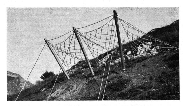
Schneenetz, Typ «Trapez». Kabelnetze KWB und Aluminiumstützen AIAG
